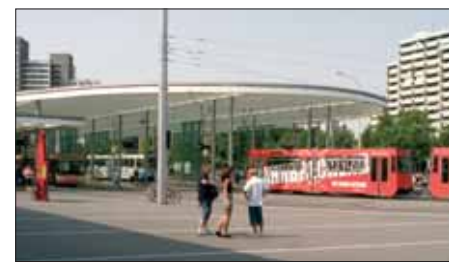
Regionalverkehrsbahnhof Braunschweig Foto: Alexander Gräbner
