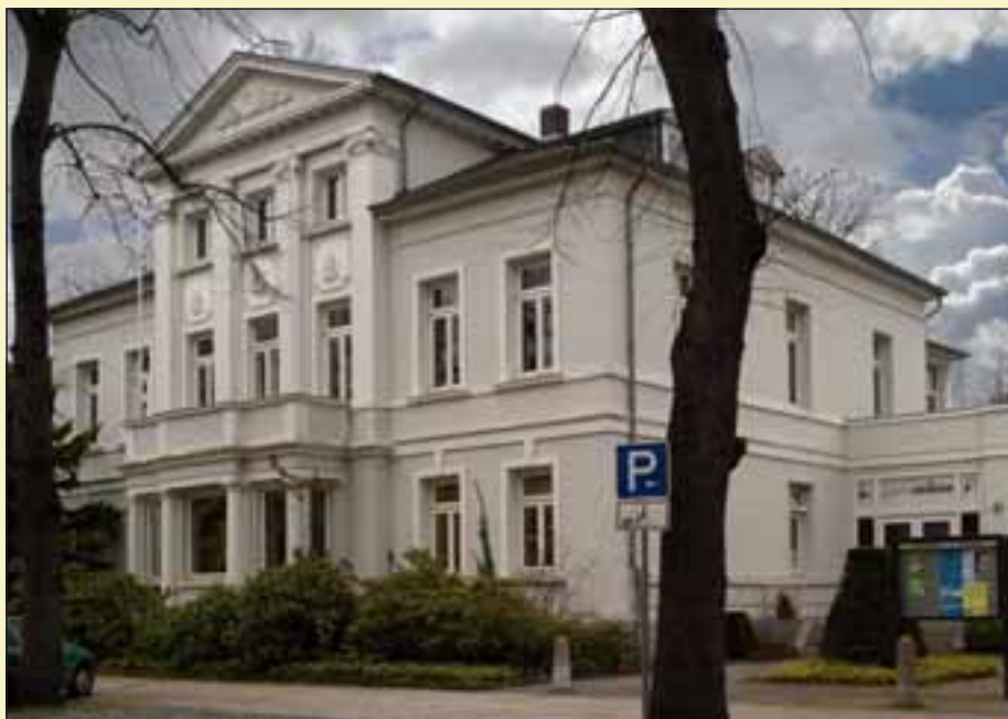
Die „Brücke“ in der traditionsreichen Villa am Steintorwall.
